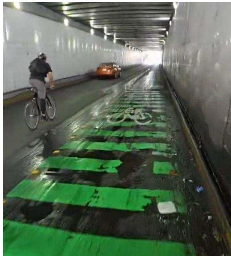
Bajo puente de Taxqueña 12
